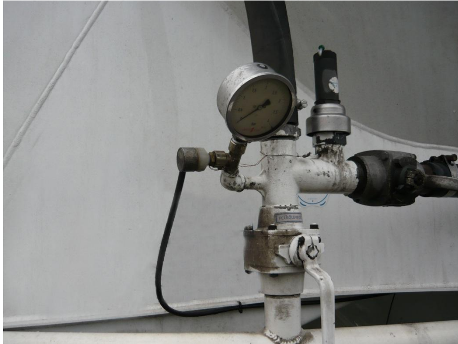
1.2. ábra. Nyomásmérő műszer helye a tartályon
