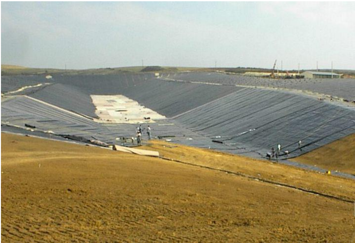
2.1. ábra: Egy épülő hulladéklerakó medence
